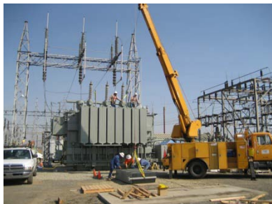
Группа SMUD, ремонтирующая трансформатор во время планового ремонта.
