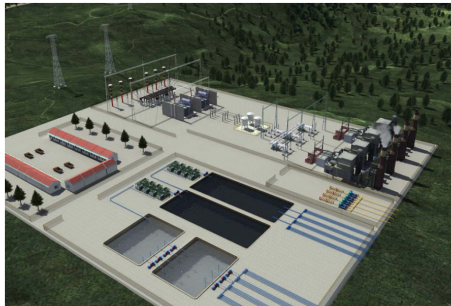
中心发电站集成的污水处理系统
