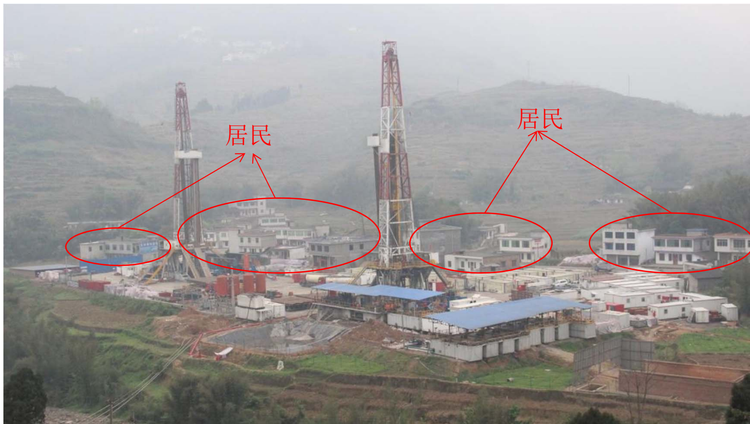
四川宜宾地区页岩气作业平台
