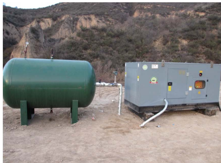
新59井场发电机组 The gas-fired generating units
